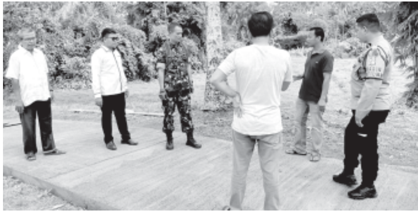
TINJAU Babinsa Koramil 05/Lubuk Alung, Sertu TNI S.Z. Damorta dan perangkat Nagari Toboh Gadang, Kecamatan Sintoga meninjau pembangunan jalan rabat beton. (agussuryadi)
